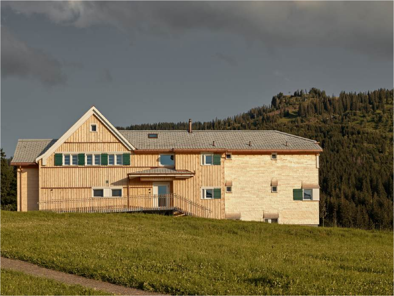
Transformierter Hauptbau mit erneuertem Zugang und ersetzttem Stallteil in Toggenburger Leisten- und Schindelbauweise
