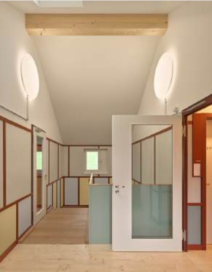
Flurtäfer mit „Opferleistenprinzip“
